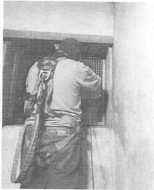
TRABAJOS DE INSTALACION
